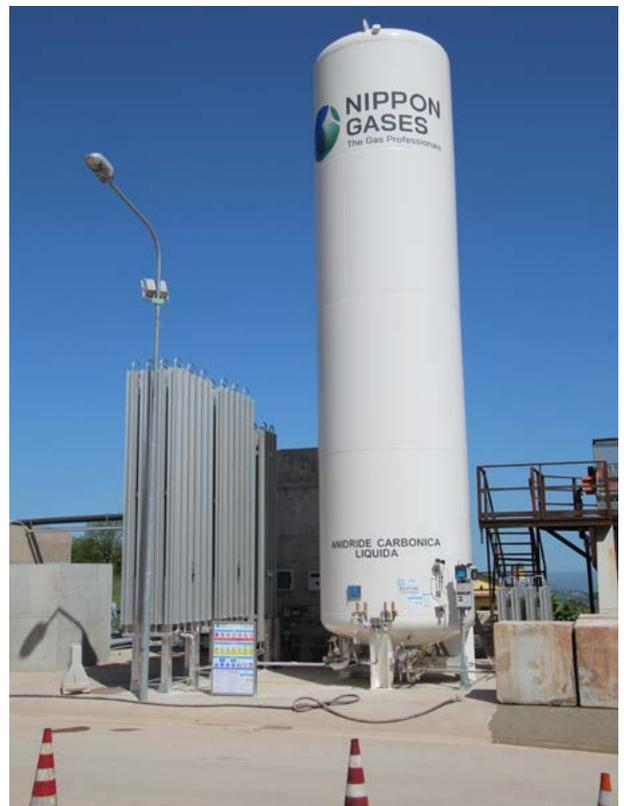
**Figura 3.** Trattamento con anidride carbonica: (a) vasca di contatto per CO<sub>2</sub> (vasca in cemento) e vaschetta di dosaggio in acciaio per coagulazione con PAC (policloruro di alluminio); b) serbatoio per CO<sub>2</sub> liquida ed evaporatore per immissione in vasca.
