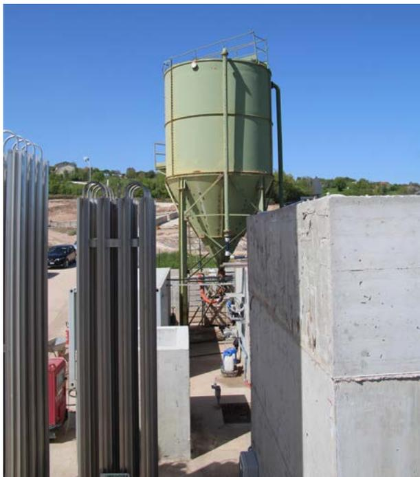
**Figura 4.** Sedimentatore verticale.
