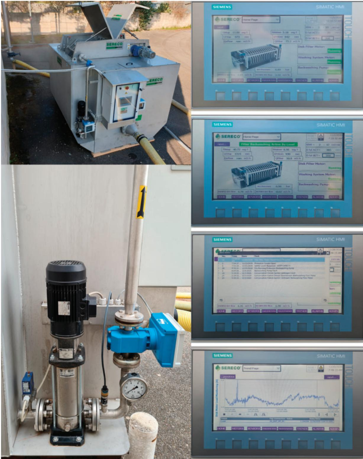
Figura 2 – Filtro SERECO tipo FDGIE installato sull'impianto di depurazione acque reflue di Putignano (BA) con particolare del gruppo di pompaggio acqua di controlavaggio e schermate HMI di monitoraggio
