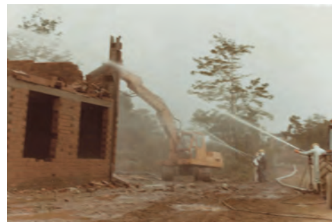
Figura 5 – Seveso, bagnatura delle superfici per limitare la risospensione di polveri
