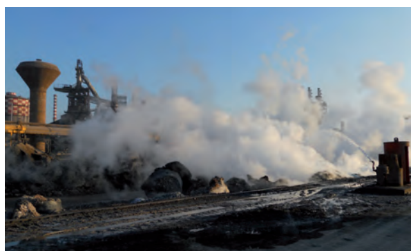
Figura 9 – Taranto, reparto Gestione Rottami Ferrosi durante ispezione ISPRA/ARPA
