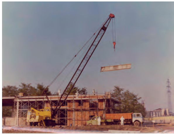
Figura 4 – Seveso, lavoratori addetti alla demolizione di manufatti
