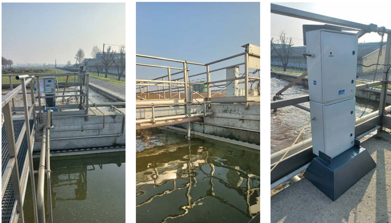
Impianto caseificio, sonda CODout in sedimentazione e Misuratore fanghi Vf30 al termine ossidazione.
