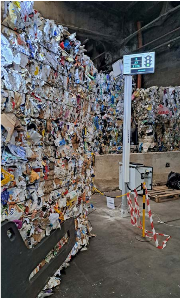
Figura 4. Piattaforma di misura e Varco RFID progetto pilota Comieco
