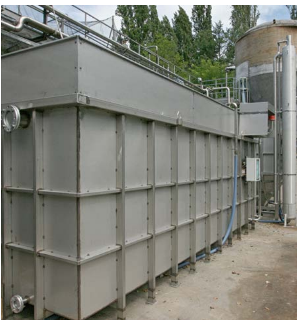
Figura 3. Sezione di ossidazione biologica a fanghi attivi.
