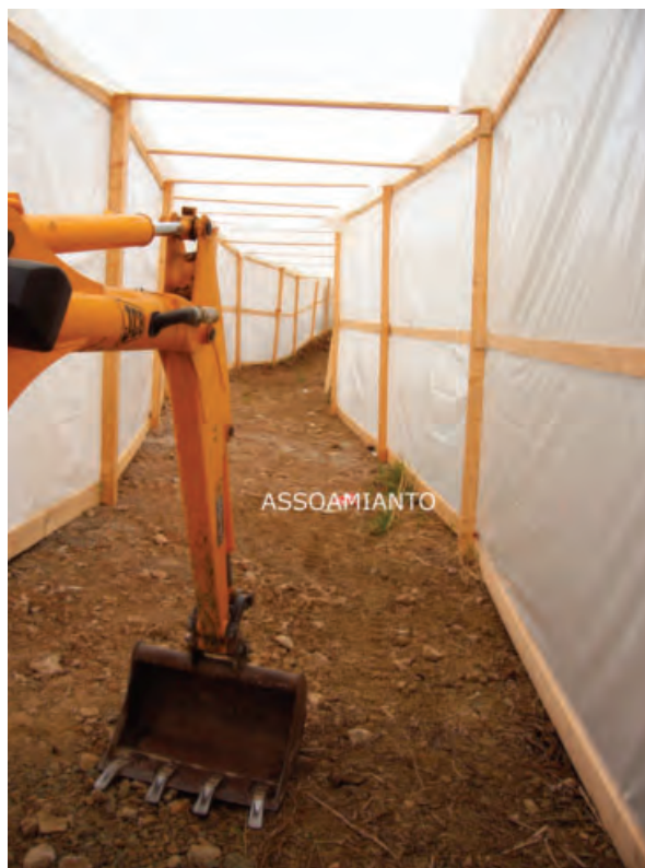
Figura 3 – Rimozione di terreno contaminato in area confinata. (Fonte: S. Clarelli, La gestione tecnica del rischio amianto, Tecniche Nuove, 2020 )
