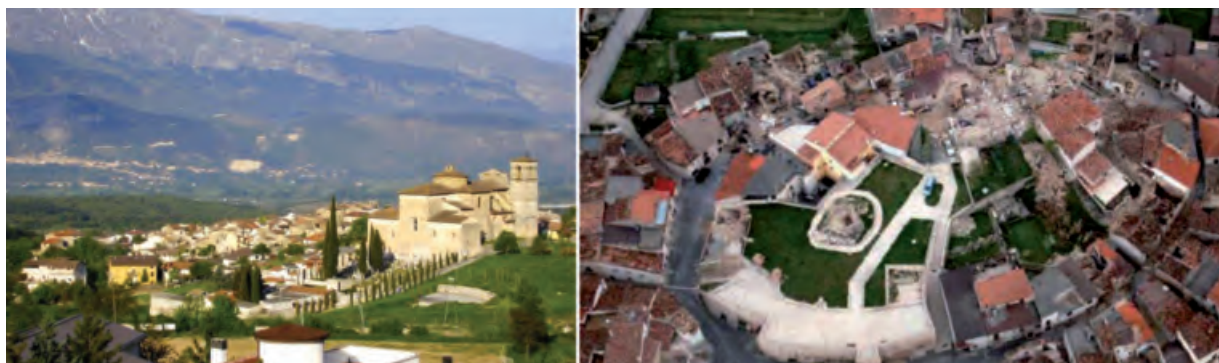
Figura 1 – Poggio Pienze: vedute aeree del centro storico prima e dopo l'evento sismico (fonte: Spacone, 2011)
